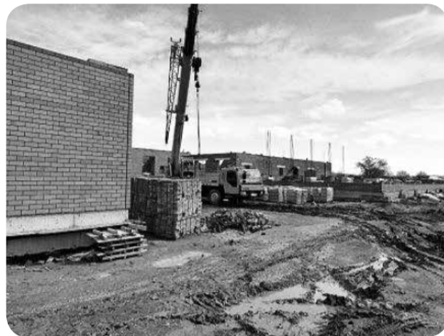
Строительство школы в селе Свобода.
