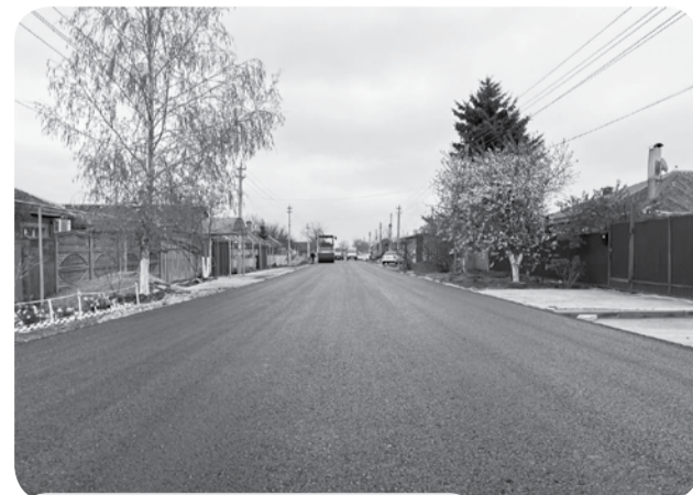
Ремонт дорог в посёлке Пятигорском.
